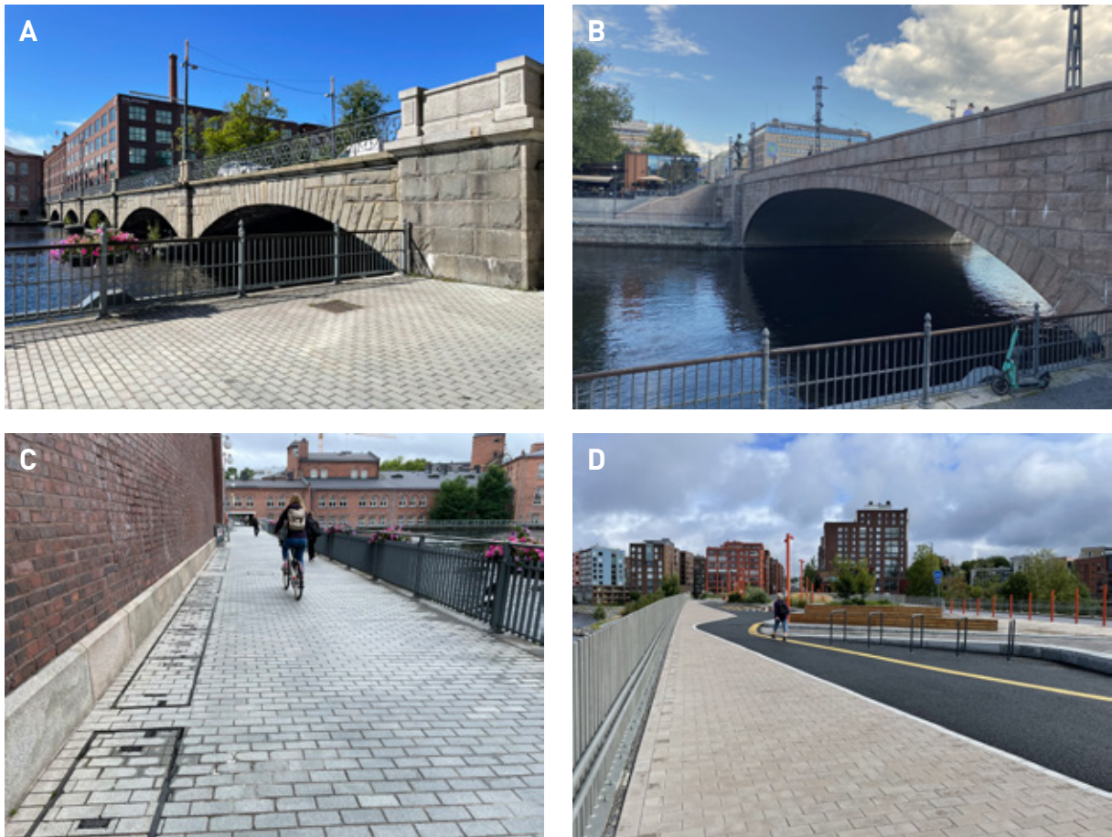
Figure 21. Bridges over the Tammerkoski Rapids. A. The Satakunnansilta Bridge (1900). B. The Hämeensilta Bridge (1929). C. The Patosilta Bridge (2000). D. The Näsin puistosilta Bridge (2023). See text for explanation. Photos: Olavi Selonen.
