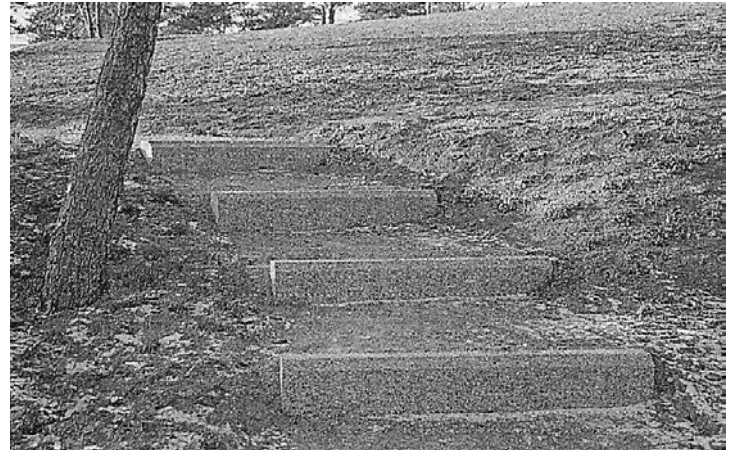
Kuva 5-44. Yksinkertainen reunakiviportas maastossa. portaatan askelmatasot ovat hiekkapintaiset. Presidentin virka-asunto, Mäntyniemi, Helsinki.
