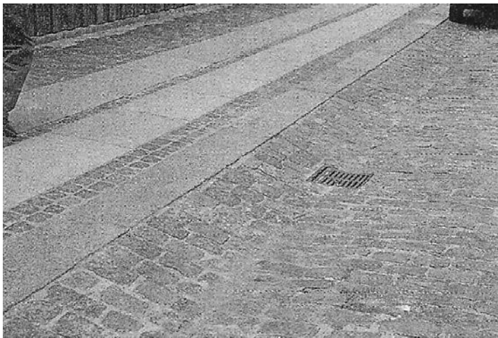
Kuva 5-24. Vesikouru noppakiveyksessä. Jalkakäytävällä kaistalaatoitus.
