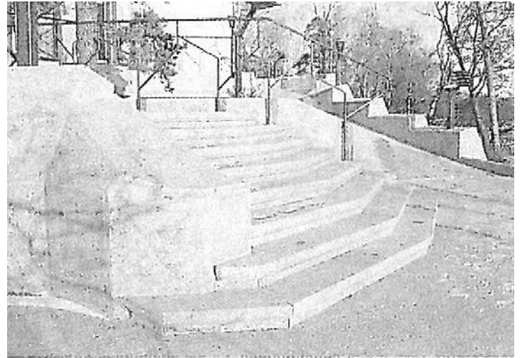
Kuva 5-38. Kivilaatoilla verhottu ulkoporras. Presidentin virka-asunto, Mäntyniemi, Helsinki.
