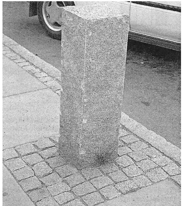
Kuva 5-60. Suorakaiteen muotoinen, lohkopintainen pollari on edullinen kivituote. Noppakiveys pollarin ympärillä kestää vaurioitumatta alustassa tapahtuvat erisuuruiset painaumat.
