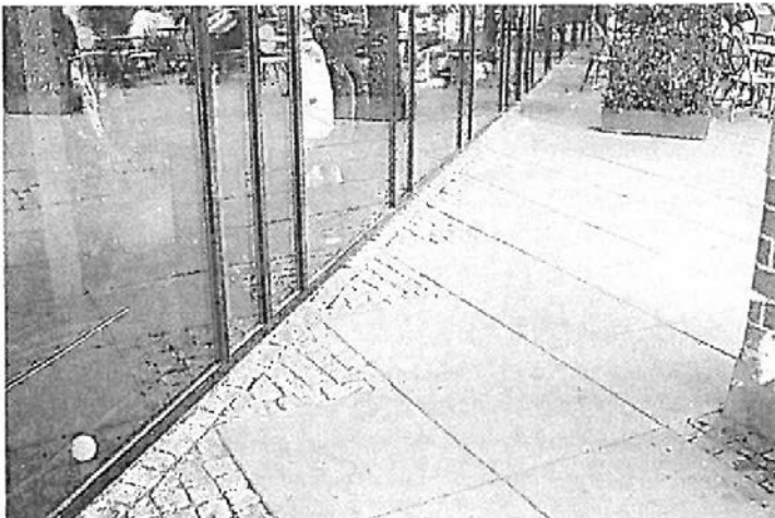
Kuva 5-5. Esimerkki noppakivien käytöstä laatoitetun tasopinnan ja rakennuksen liittymäkohdassa.
