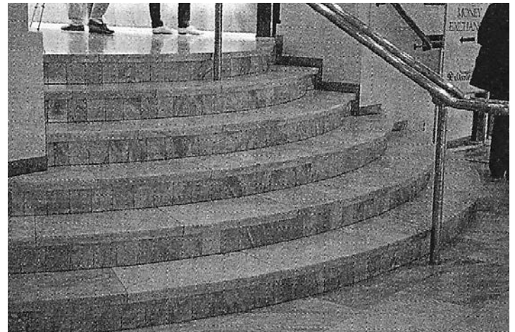
Kuva 4-23. Kivilaatoilla päällystetty kaarevan muotoinen kiviporras suurehkon pankin konttorissa Helsingissä.
