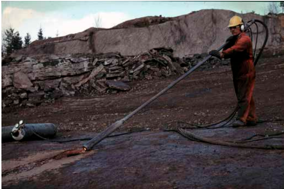
Figur 11. Jet bränning i sten, lågans temperatur ca 2500 °C. Metoden användes för att göra sömmar i kvartsrika bergarter, t.ex. vid öppnandet av pallens ändor. Sömmens bredd var 100-150 mm. På grund av den höga bullernivån och dammmissionerna används metoden inte längre. Foto: Veli Juhani Hänninen.
