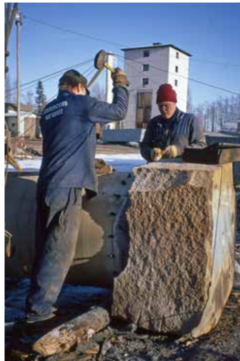
Figur 19. Styckning av valsens botten: kilar slås ned. Foto: Arto Peltola.
