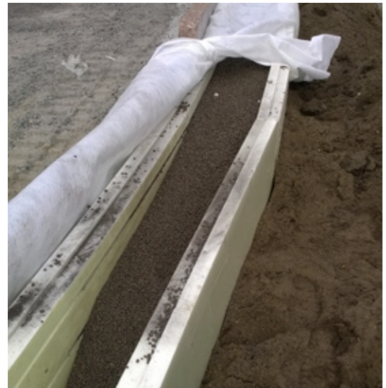
Figure 4. Frost protection of cheek stone slabs. Photo: Miika Tolonen. Kuva 4. Poskikivien routasuojaus. Kuva: Miika Tolonen.
