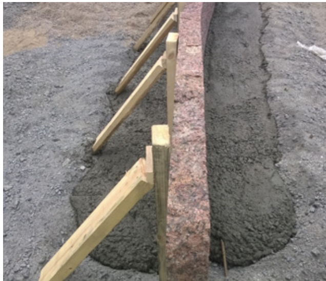
Figure 3. Casting of cheek stone slabs. Photo: Miika Tolonen. Kuva 3. Poskikivien valu. Kuva: Miika Tolonen.
