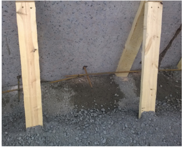
Figure 2. Reinforcement of cheek stone slabs. Photo: Miika Tolonen. Kuva 2. Poskikivien raudoitus. Kuva: Miika Tolonen.
