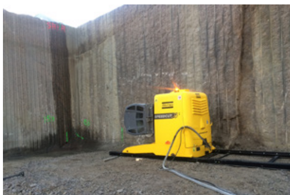
Kuva 14. Kamin päädyn avaus timanttivaijerisahalla graniittilouhimolla. Kuva: Pauli Salmela.
