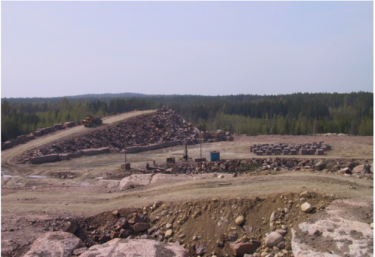
Kuva 15. Sivukivinen meluvalli rakenteilla. Kuva: Antonia Ramsay.
