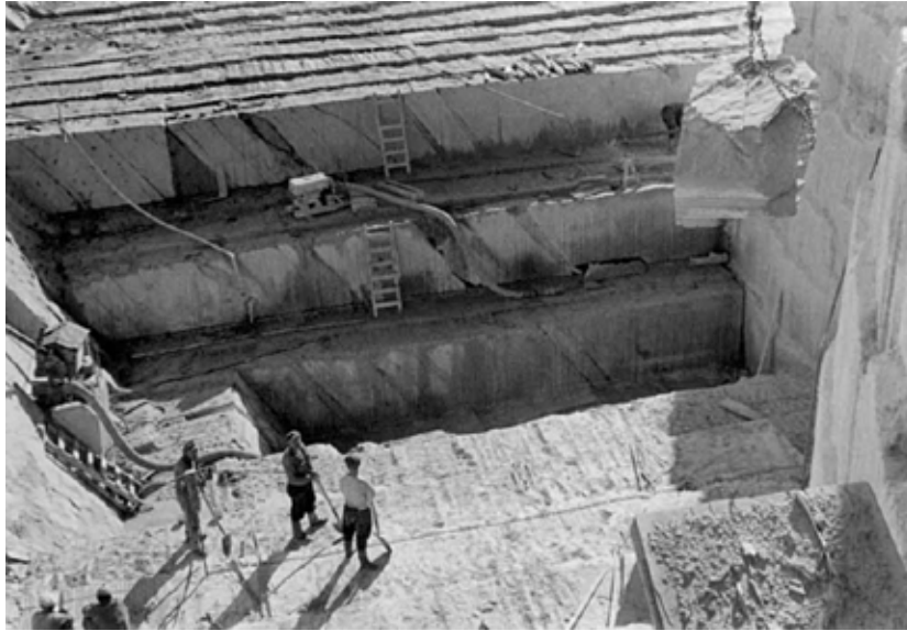
Suomen Vuolukivi Oy's soapstone quarry in Kärenvaara. Nunnanlahti, Juuka, Finland. 15.9.1951. Photo: Herman Stigzelius, Geological Survey of Finland.
