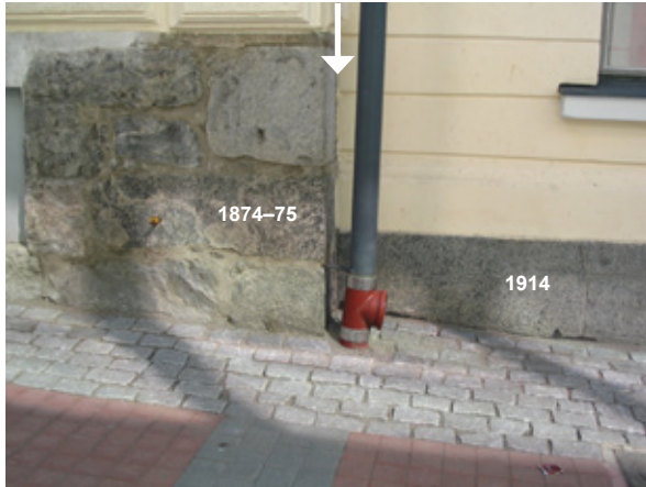
Kuva 4. Hallikadun seinän sokkeli. Rännin vasemmalla puolella vuoden 1875 sokkeli ja oikealla puolella vuoden 1914 laajennuksen sokkeli. Kuva: Heikki Lukkarinen.
