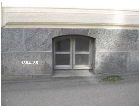
Kuva 6. Vuoden 1885 sokkelin ikkuna-aukko Puijonkadun puolella. Kuva: Heikki Lukkarinen.
