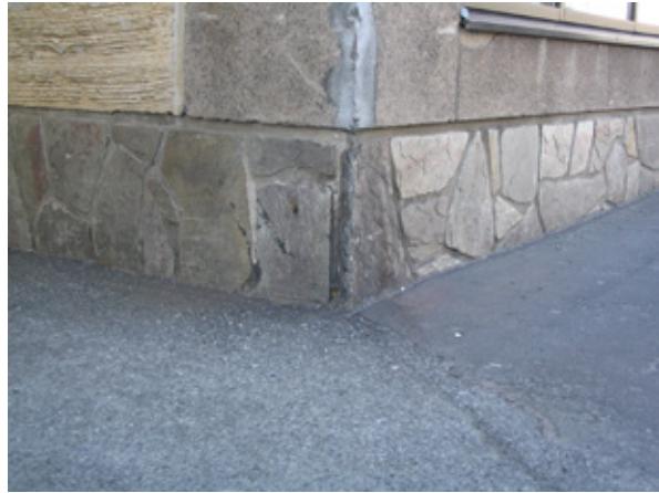
Kuva 25. Nilsin kvartsiittilaattoja kivijalassa. Kuva: Heikki Lukkarinen.
