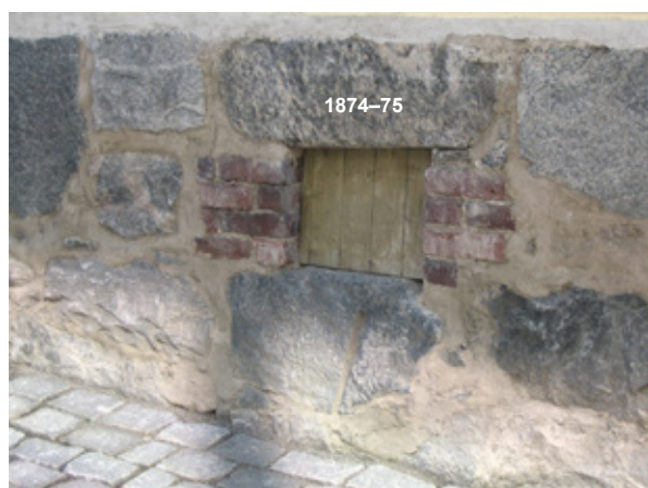
Kuva 3. Lyseon vuoden 1875 laajennuksen sokkelin tiilireunainen tuuletusaukko Hallikadun puolella. Kuva: Heikki Lukkarinen.
