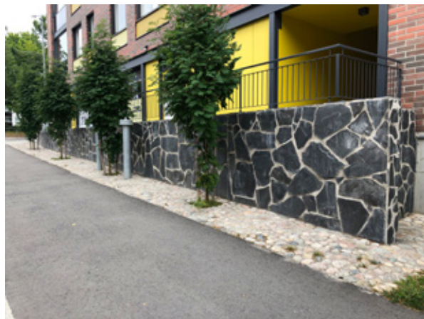
Kuva 27. Oriveden liuskelattoa portaikossa. Kuva: Olavi Selonen.
