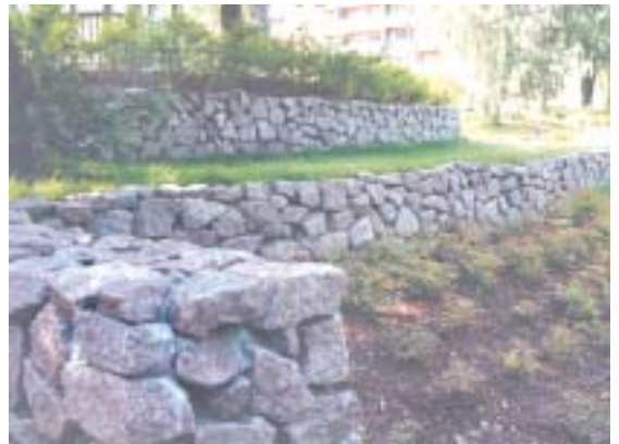
Sivukivestä rakennettu muuri.
