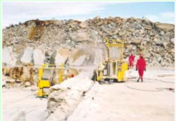
Vuolukiveä louhitaan ketjusahoilla, joilla sahataan sekä pystyettä vaakasuoraan, jolloin saadaan irrotetuksi koko louhimon levyinen letka. Kivilohkit irrotetaan letkasta pyöräkuormaajalla. Sivukiveä poistetaan räjäyttämällä.
